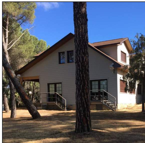
Edificio D, revestido de madera
